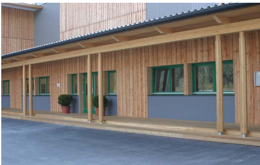
Lärchen Rundsäulen beim Noritec Leimbinderwerk
