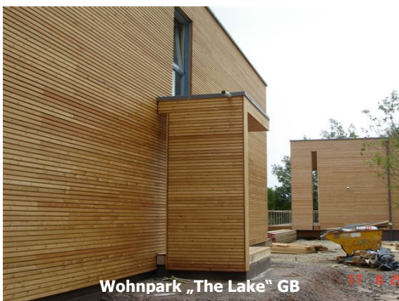
HNT-Tafelement 40 Stufenfalz-Lärche auf Fichtenunterlage (Qualität AB) wasserfest verklebt. Format: 31 x 189 x 3970 mm (Deckmaß: 181 mm) (im Bild: Qualität "Select")
