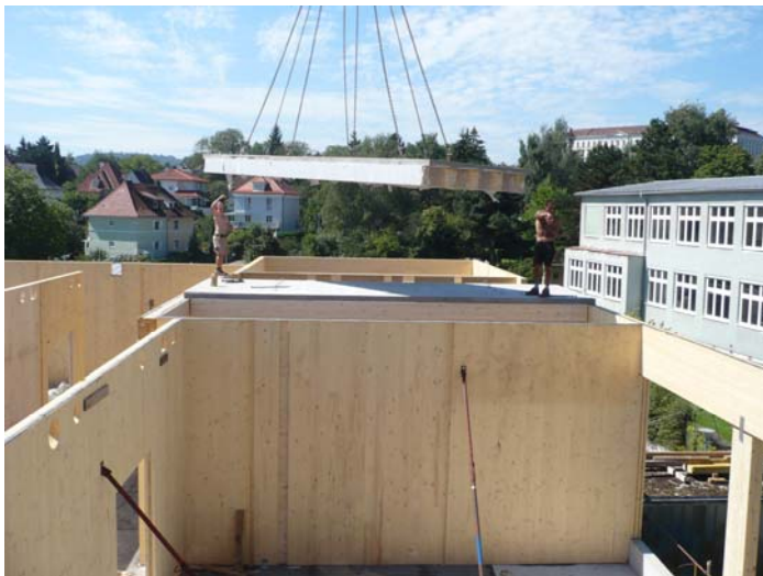
Einschwenken einer HBV Deckenplatte bei einem Holzplattenbau
