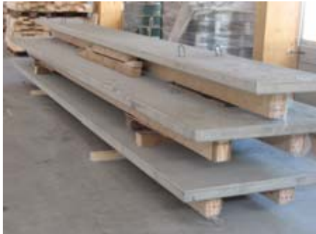
HBV Deckenelemente vor dem Einbau
