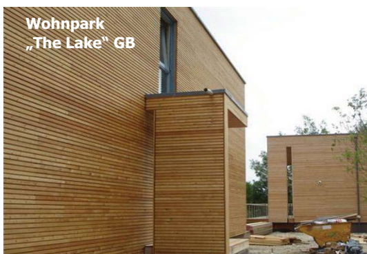
HHZ-Tafelement 40 Stufenfalz-Lärche auf Fichtenunterlage (Qualität AB) wasserfest verklebt. Format: 31 x 189 x 3970 mm (Deckmaß: 181 mm) (im Bild: Qualität "Select")
